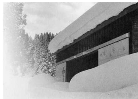
雪室（施設内部に雪を貯蔵）
