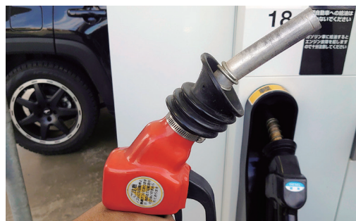
リカバリーノズルで給油しながらベーパーを回収
