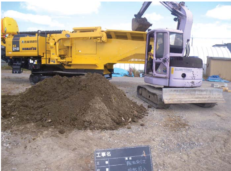
汚染土に液体中和剤を噴霧することで改良土として再利用可能になる。
