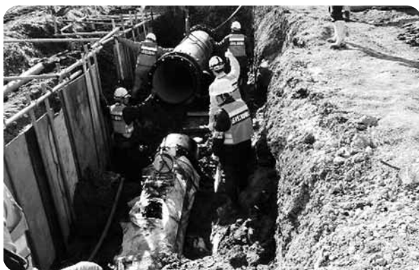
水道本管復旧作業
